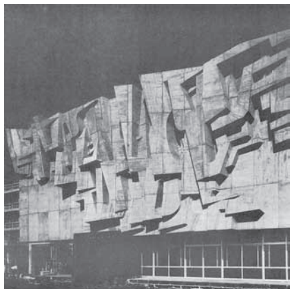
平塚市庁舎議事堂の外壁
